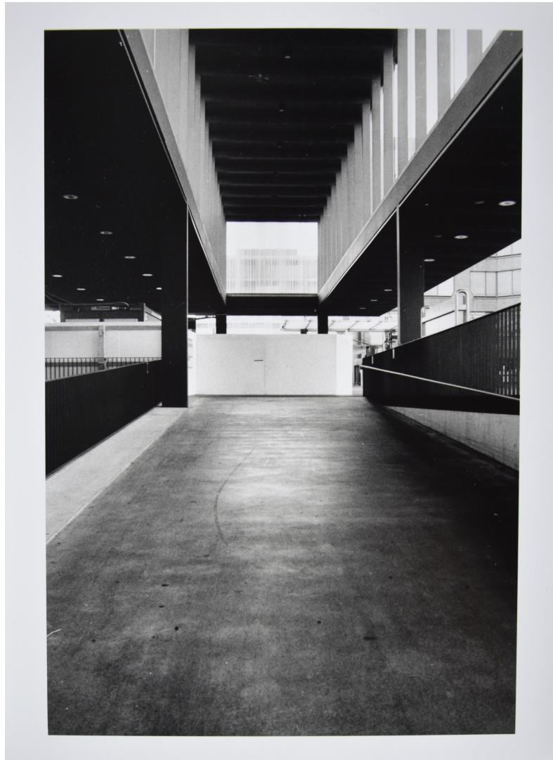
Abbildung 32 Bahnunterführung Zürich Oerlikon 97
