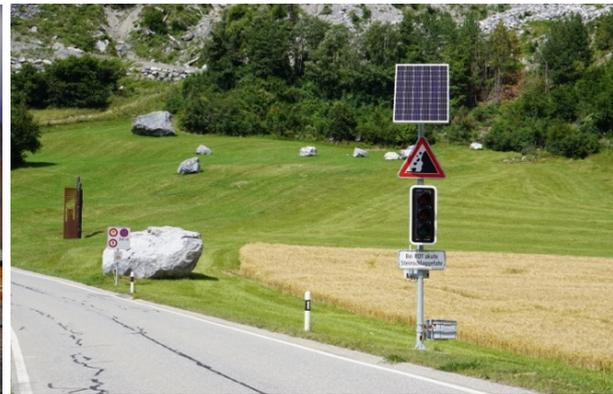
Abbildung 27: Bemerkte die Kamera Steinschlagaktivität, schaltet das Lichtsignal auf Rot. (eigenes Bild)
