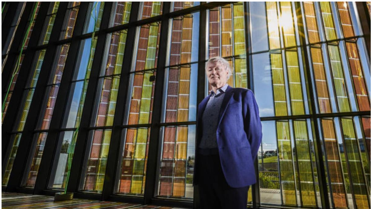
Abbildung 1 Der Erfinder der Grätzel-Zelle Michael Grätzel vor dem SwissTech Convention Center in Lausanne. Das Gebäude nutzt Grätzel-Zellen zur Stromerzeugung.
