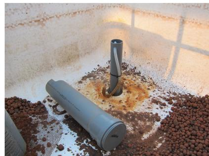
Abbildung 7 Installierung des Glockensiphons
